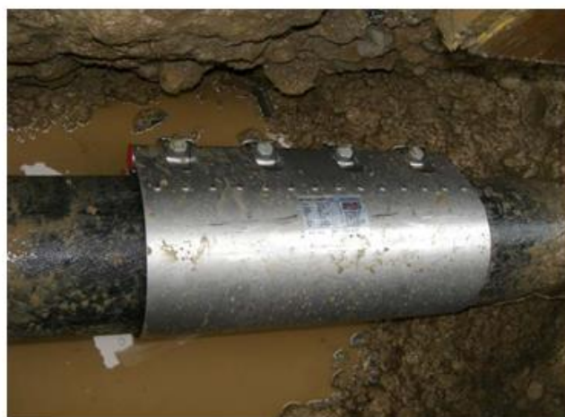
Saniranje većih područja oštećenja, do 250mm
